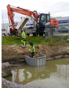
Bilder från Flexiclean. Filtervägg vid mynning i recipient eller i samlingsbrunn.
