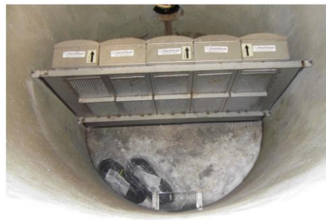
Bilder från Flexiclean. Filtervägg vid mynning i recipient eller i samlingsbrunn.
