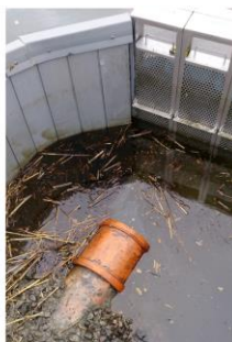
Bilder från Flexiclean. Filtervägg vid mynning i recipient eller i samlingsbrunn.
