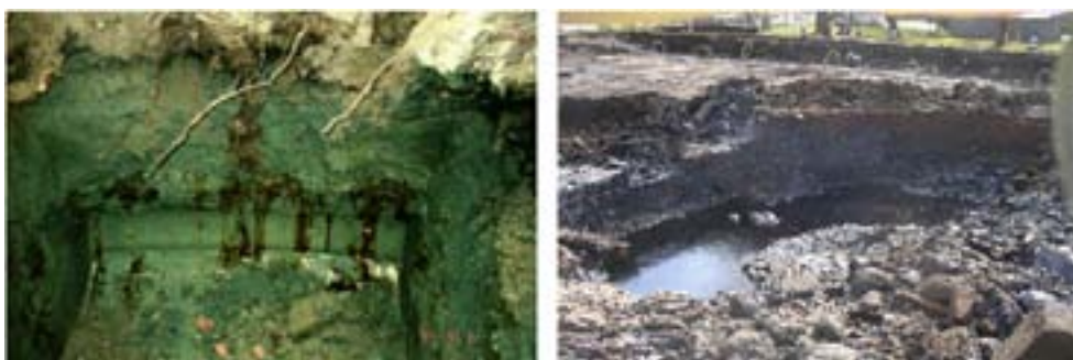
Figur 6-4. Foton från en kreosotimpregneringsanläggning respektive en gasverkstomt som sanerats. På båda platserna upptäcktes betydande mängder DNAPL under grundvattenytan på stora jorddjup.
