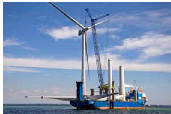
➤ Installation av vindkraftverk vid Lillgrund
