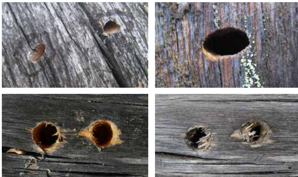
Figur 10. Övre raden: Till vänster kläckhål som bedöms vara 1-2 år gamla; foto 29 juli 2011 (Sture Marklund). Notera att yttersta veden i hålen till vänster har börjat gråna. Till höger ett årsfärskt kläckhål tillkommet efter 29 juli 2011, fotograferat den 1 november samma år (Pekka Bader).
