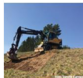
Foto: Tommy Karlsson Schaktning av sandblotta i sydvänd sluttning.
