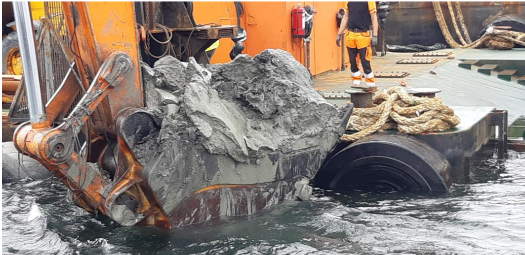
Figur 2 Sediment i skovl under prøvegravning. Bemærk at materialet er sammenhængende (kohæsivt) og vil danne klumper i forbindelse med den efterfølgende klapning.
