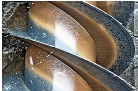
Del av en arkimedesskruv som pumpar vattnet till en högre nivå på Nykvarnsverket, Tekniska verken i Linköping AB.
