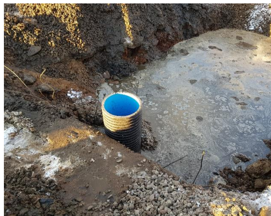
Figur 27 och 28. Perforerad pumpbrunn före installation och installerad pumpbrunn i H6. PFAS-hinna.
