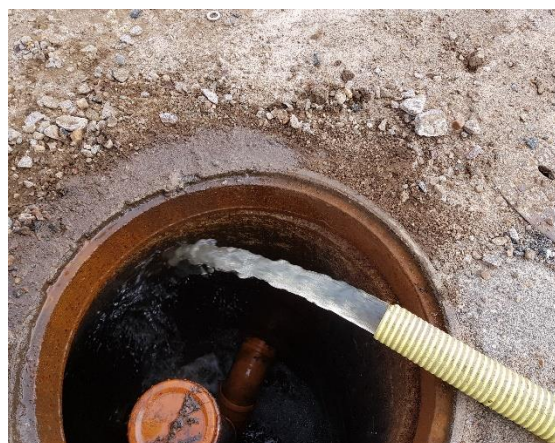
Figur 35 och 36. Utsläpp av renat vatten, utsläppspunkt i dagvattenbrunn i sydväst på fastigheten.
