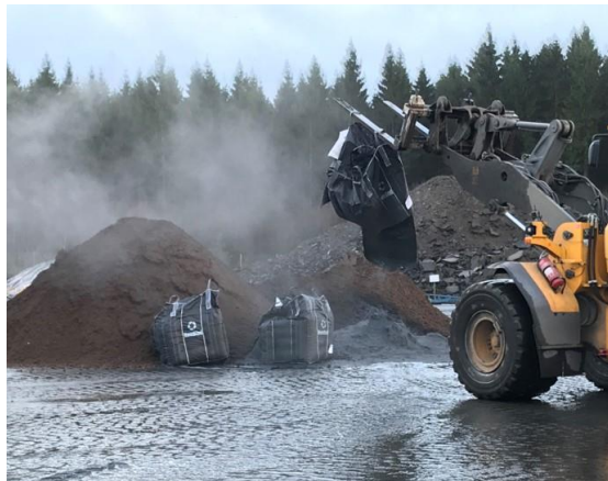
Figur 43 och 44. Behandling på HEM i Vankiva, inblandning av PFAS-stabiliseringsmedel, RemBind.
