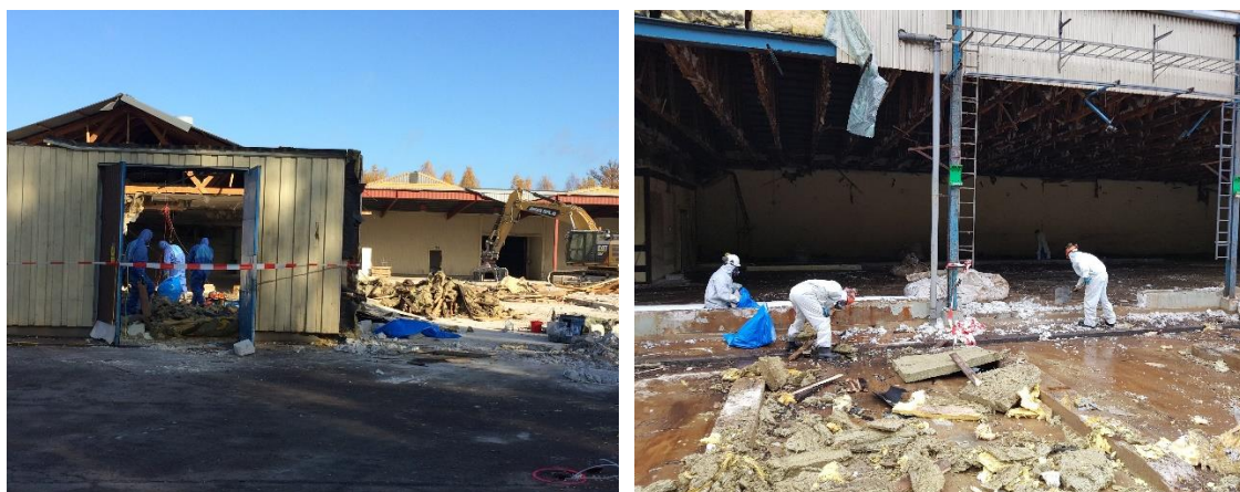
Figur 9 och 10. Manuell rivning och asbestsanering.
