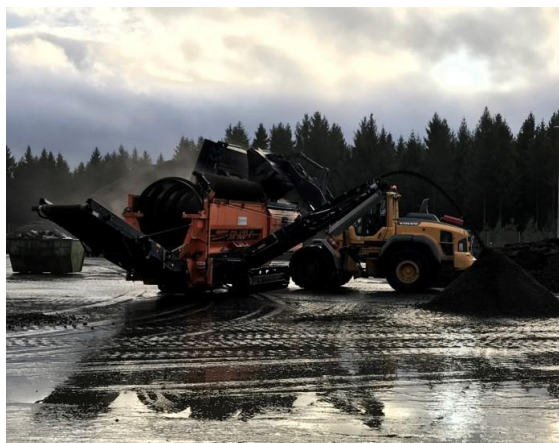
Figur 45 och 46. Behandling på HEM i Vankiva, inblandning av PFAS-stabiliseringsmedel, RemBind.
