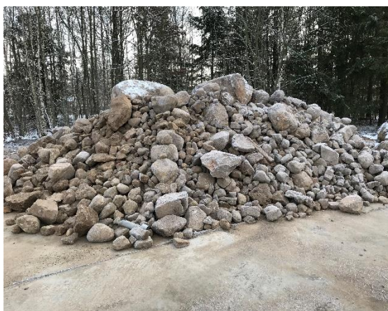
Figur 17 och 18. Utsortering av "storsten" genom harpning med skiktsskopa. Sten för återfyllnad.
