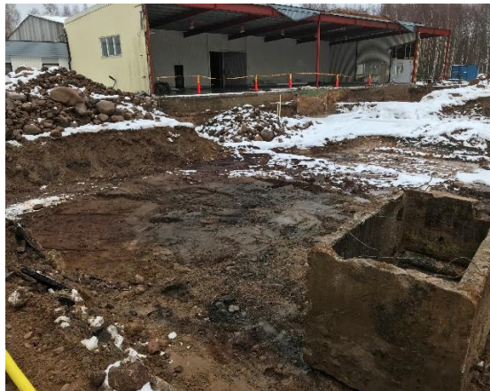
Figur 19 och 20. Exempel på påträffade kassuner under Hall A och Hall B, den senare makadamfylld.
