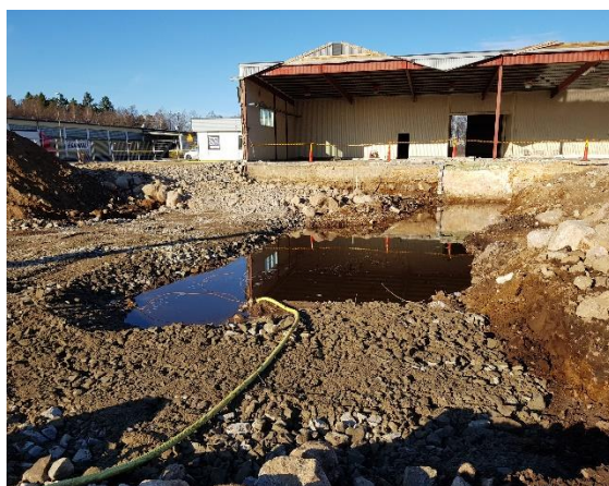
Figur 29 och 30. Vattenfylld schakt och PFAS-hinna på vattnet
