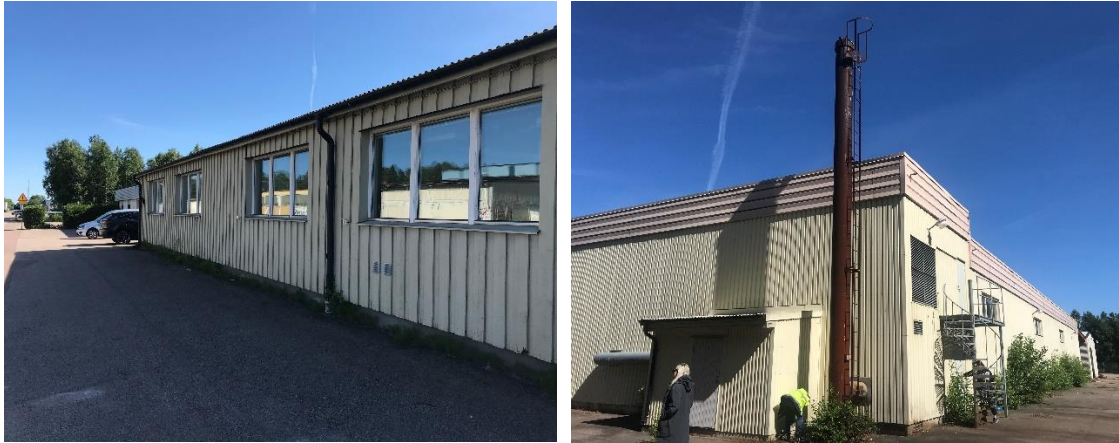
Figur 1 och 2. Före rivning utvändigt, fasad Hall A mot gatan i öster och vy Hall D från sydöst.
