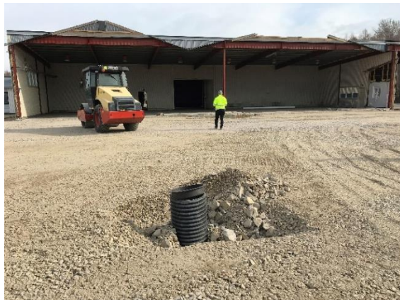
Figur 25 och 26. Återställd yta, kvarlämnad pumpgrop/pumpbrunn och bevarade grundvattenrör
