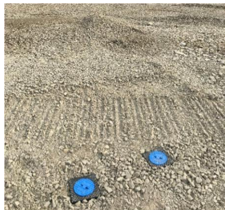
Figur 25 och 26. Återställd yta, kvarlämnad pumpgrop/pumpbrunn och bevarade grundvattenrör
