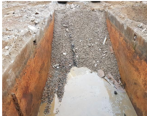
Figur 19 och 20. Exempel på påträffade kassuner under Hall A och Hall B, den senare makadamfylld.
