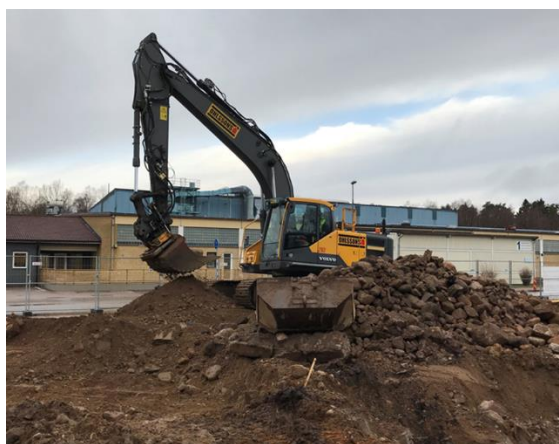
Figur 17 och 18. Utsortering av "storsten" genom harpning med skiktsskopa. Sten för återfyllnad.
