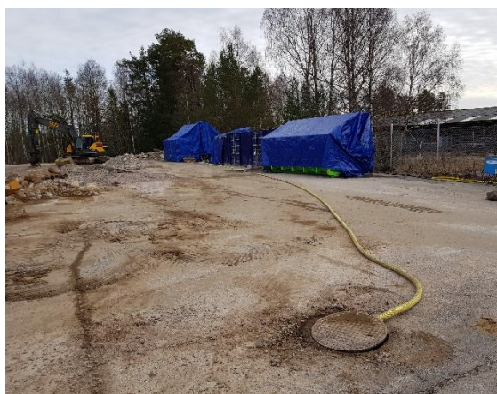
Figur 35 och 36. Utsläpp av renat vatten, utsläppspunkt i dagvattenbrunn i sydväst på fastigheten.
