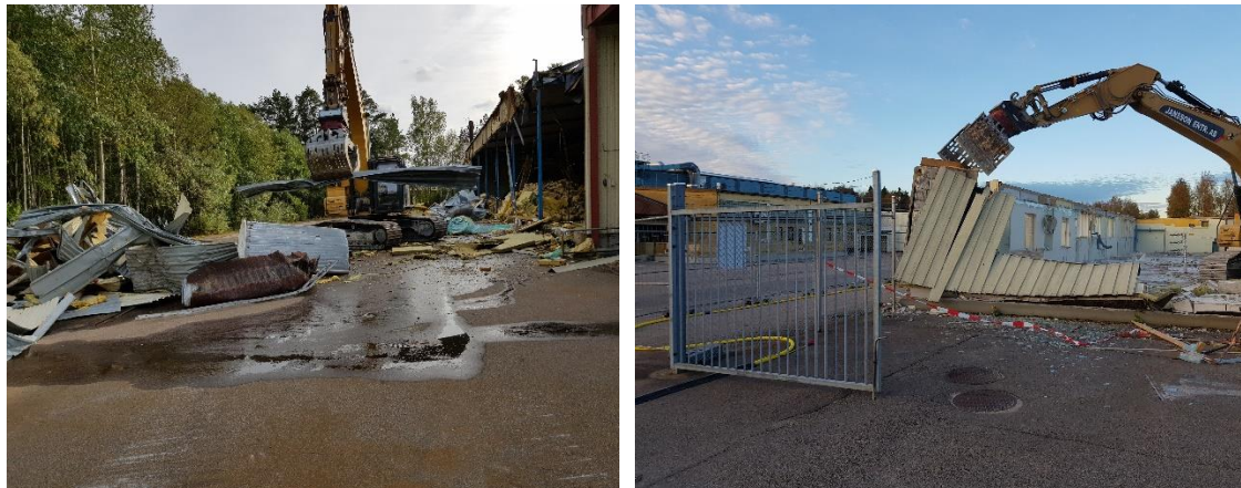
Figur 7 och 8. Rivning med maskin
