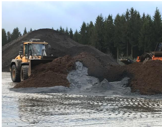
Figur 43 och 44. Behandling på HEM i Vankiva, inblandning av PFAS-stabiliseringsmedel, RemBind.
