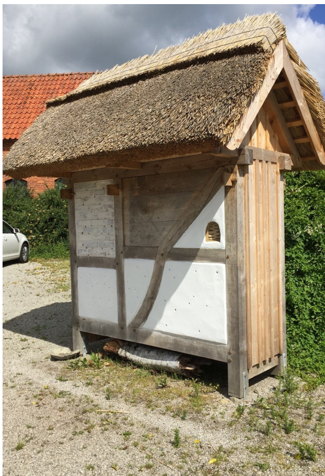
Figur 1. Bihotell i traditionell skånsk byggnadsstil, hantverksmässigt utfört och uppsatt vid Hylkegården 1 km SV om Brantevik.
