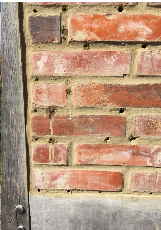
Figur 2. Hörnet av frontväggen efter ombyggnad, murad och fogad med lerbruk, maj 2018. De större hålen till höger når in till lerstensmoduler i den bakomliggande lerstensväggen.
