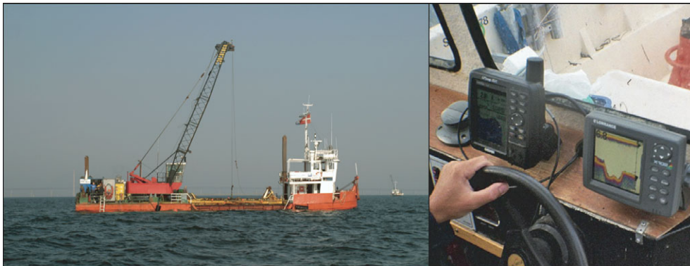
Figur 3. Till vänster: muddarfartyg förbereder botten för installation av gravitationsfundament vid Lillgrund. Till höger: den muddrade gropen vid fundament D03 återges på provtagningsfartygets ekolod.
