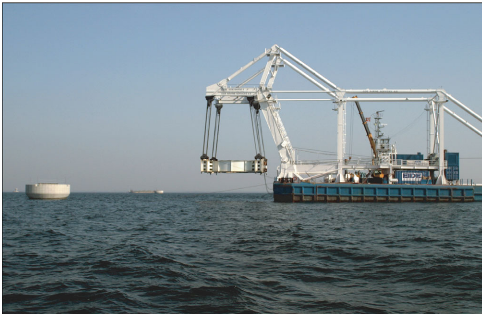
Figur 1. Konstruktionsarbete vid Lillgrund vindpark i Öresund. Installering av gravitationsfundament.
