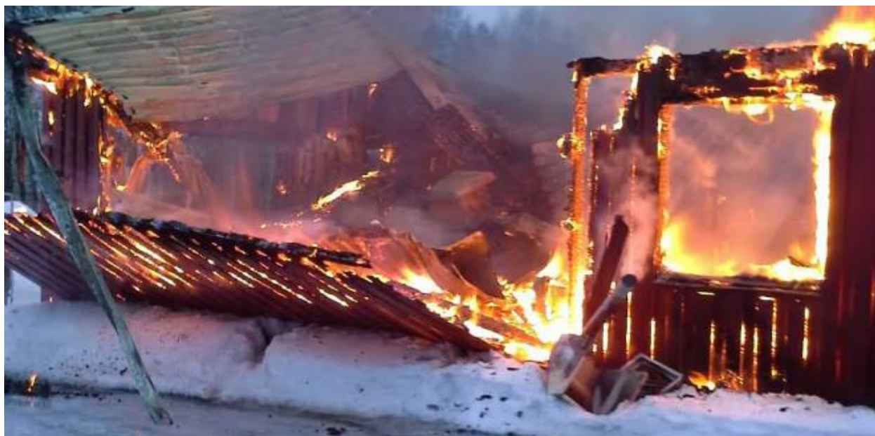
Figur 1. Täfteå reningsverk, nerbrunnet till grunden 2018. 2
