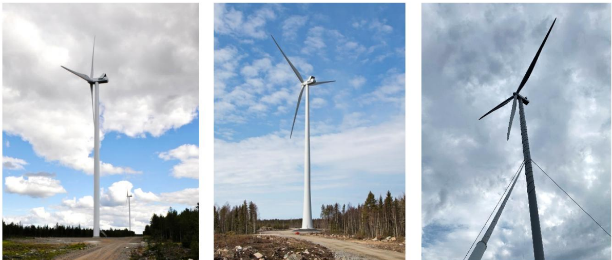
Bild 11. Till vänster visas ett exempel på ett cylindertorn i stål, i mitten ett hybridtorn och till höger ett torn med stag. (Bilder: FCG och Jarkko Finnilä, Carelin)
