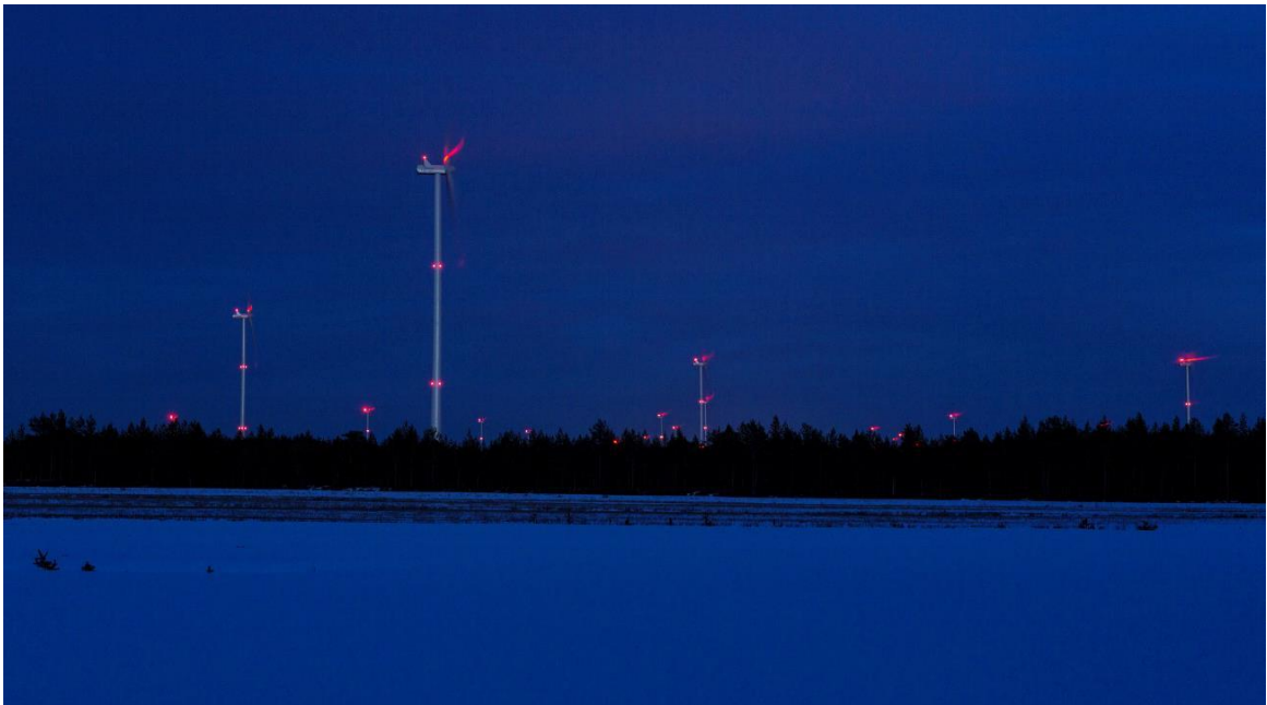
Bild 13. Fast rött fastskenande flyghinderljus i mörker.
