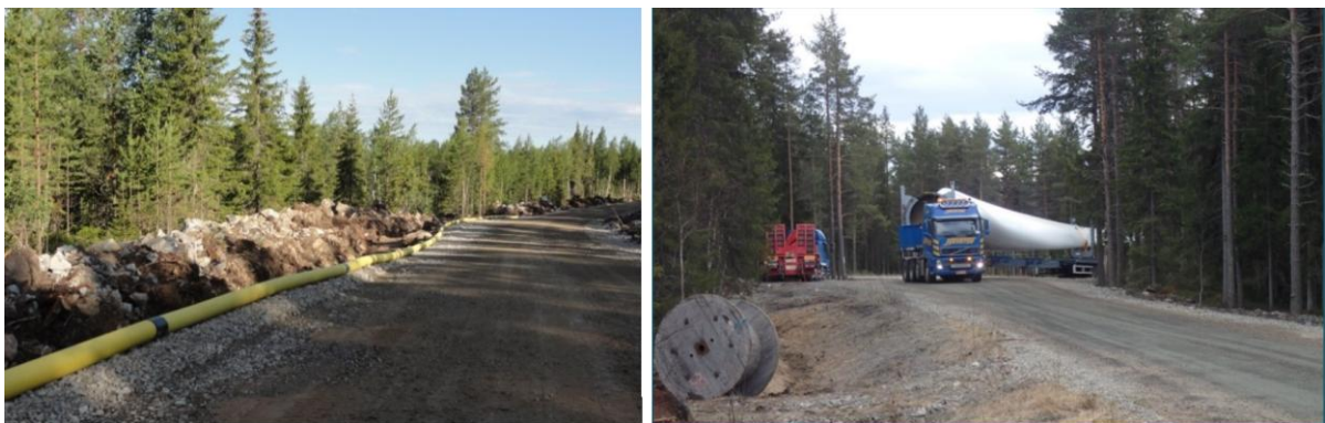
Bild 17. (Till vänster) Exempel på en byggväg och serviceväg i vindkraftsparken. Vägarna används bland annat för att transportera betong, grus och vindkraftverkskomponenter samt under vindkraftsparkens driftsskede för servicekörningar. Markkabeln placeras i en dikeskanal vid vägkanten. (Till höger) Transport av vindkraftskomponenter som specialtransporter. (Bilder: FCG).
