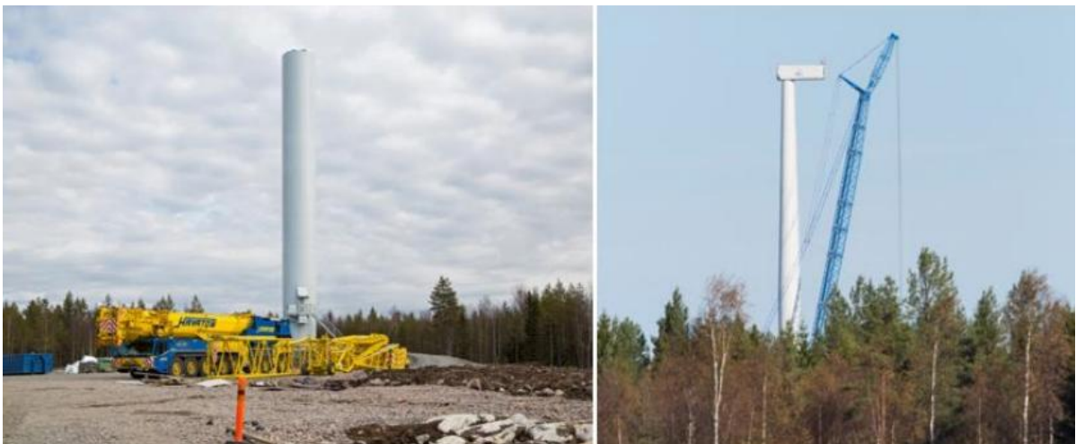
Bild 22. Monteringen av ett vindkraftverk. (Bilder: FCG)
