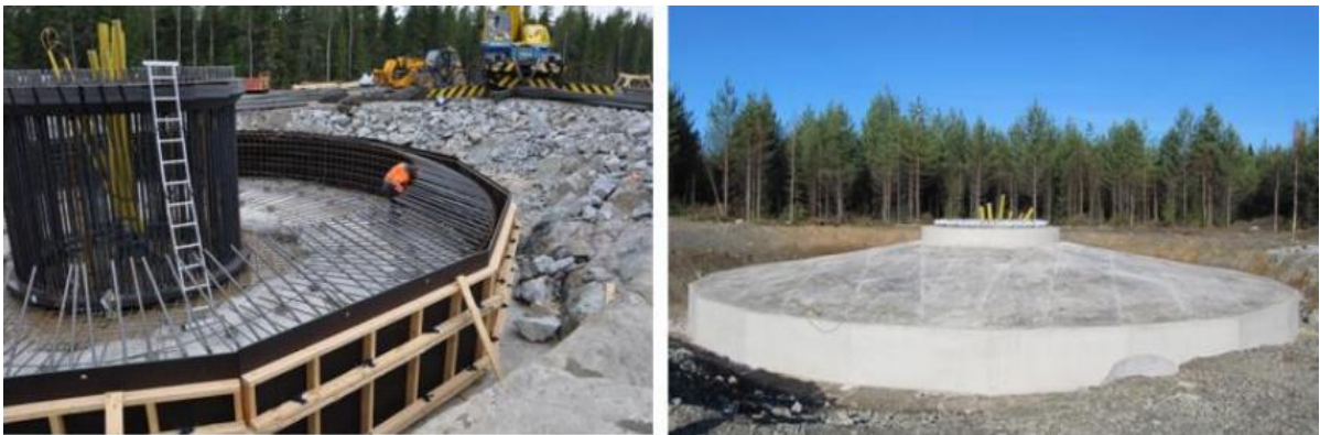
Bild 21. Byggandet av fundamentet till ett vindkraftverk. (Bilder: FCG)
