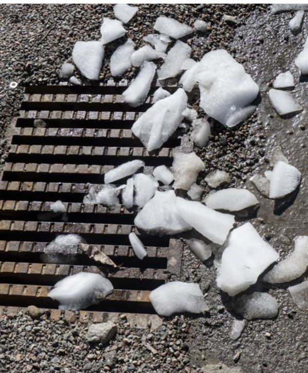
En dagvattenbrunn är avsedd att samla upp dagvatten från hårdgjorda ytor så som gator, parkeringar och trottoarer. Foto: Naturvårdsverket.
