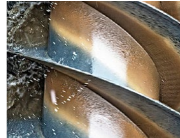
Del av en arkimedesskruv på Nykvarnsverket, Tekniska verken i Linköping AB. Foto: Staffan Ågren/Naturvårdsverket.
