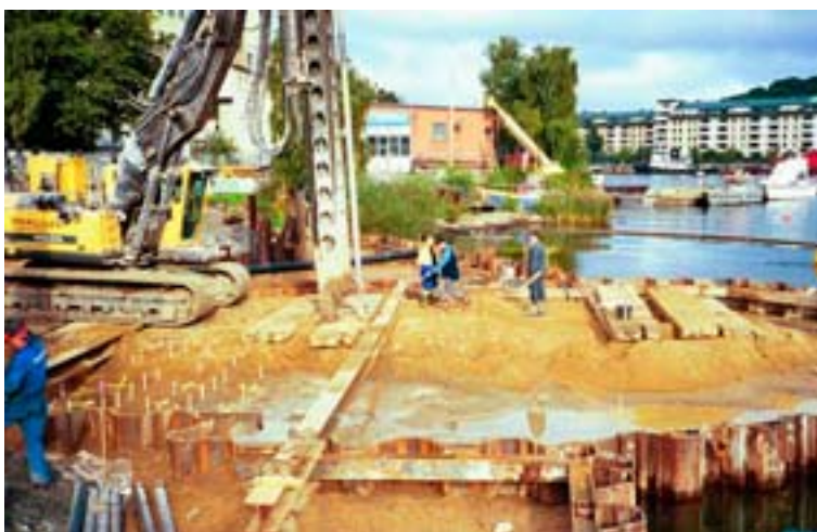
Figur 11. In-situ solidifiering/stabilisering med pelare i Hammarby sjöstad.
