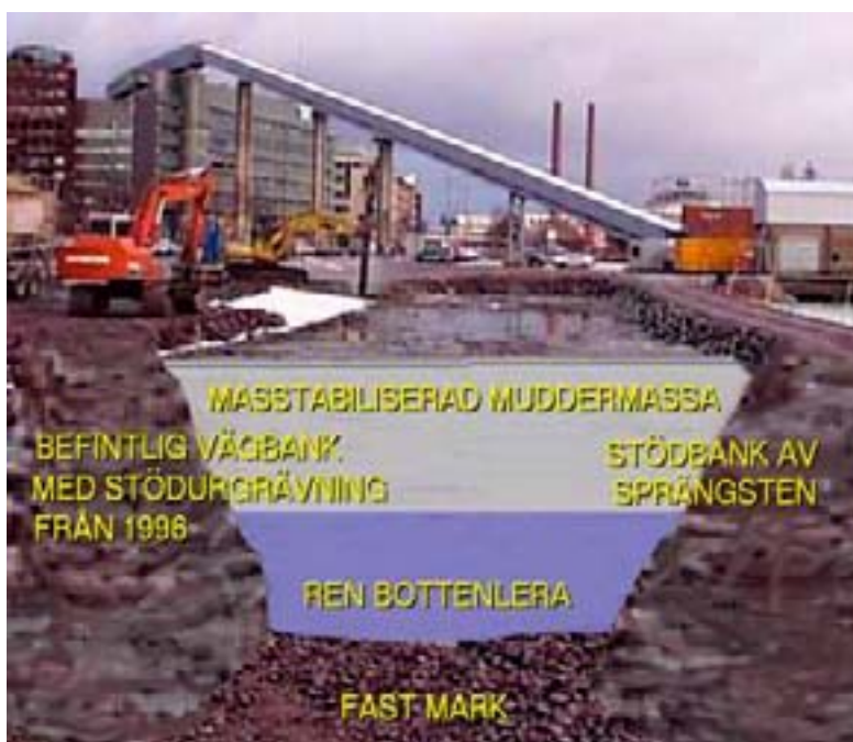
Figur 13. Konstruktion och stabilisering i Sörnäs strand
