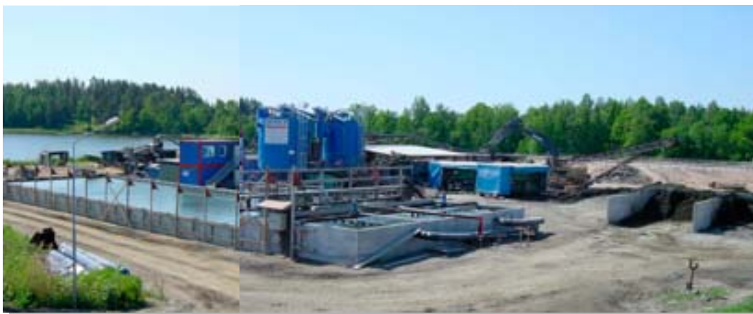
Figur 9. Grovsortering (vänster bak), avvattningsanläggning (mitten) och blandningsenhet (höger) i Örserumsviken.
