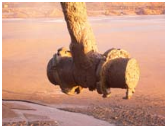
Figur 7. Stabilisering/solidifiering av muddermassor i Nordsjö hamn, Helsingfors (Foto Bo Svedberg)
