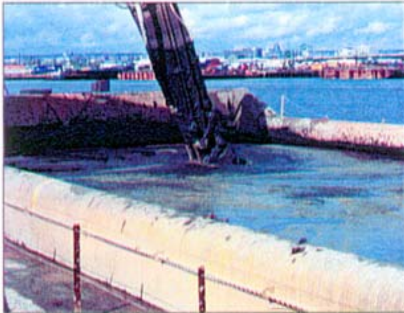
Figur 24. Utförande av stabilisering/solidifiering vid Port Newark.
