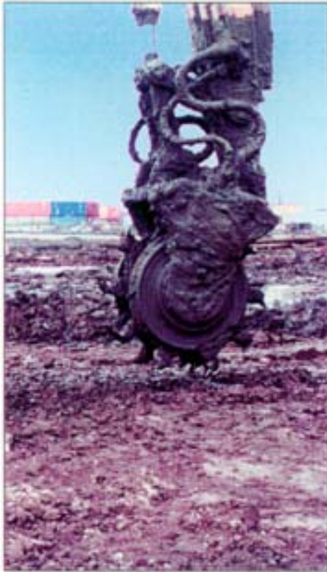
Figur 23. Ett roterande blandningsverktyg för stabilisering/solidifiering vid Port Newark.
