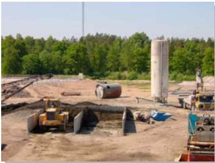
Figur 10. Blandningsstation för stabilisering av avvattnade muddermassor i Örserumsviken.
