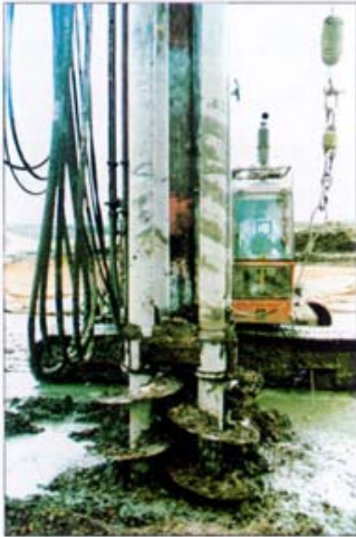
Figur 25. Använd Colmix-utrustning för S/S av föroreningar (Al-Tabbaa, Perera, 2002).
