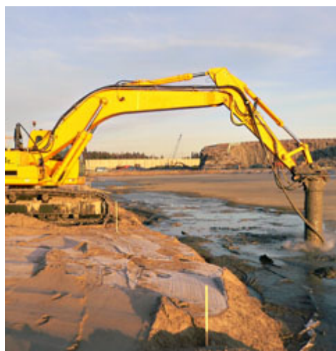
Stabilisering och solidifiering av förorenad jord och muddermassor, en rapport från Hållbar Sanering. Foto: Bo Svedberg.
