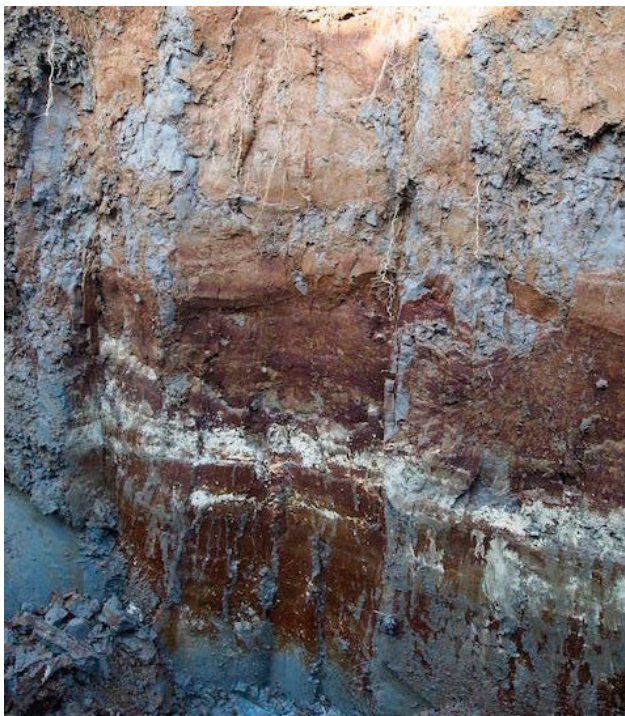
Figur 11. Utfällning av vitfärgad kalksten på sur och järnrik sprickyta i sur sulfatjord i Österbotten (Risöfladan), efter att kalkstenssuspension injicerats i jorden. Foto: Sten Engblom.
