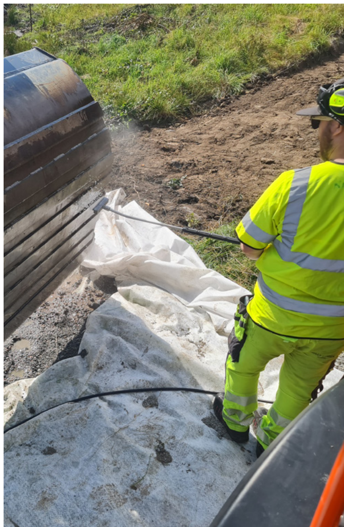
Foto: Jeremy McClure. Rengöring av grävskopa över geotextil. Säkerställ att lokalt gällande avloppsvattenregler och föreskrifter för vattenrening följs innan du tvättar.
