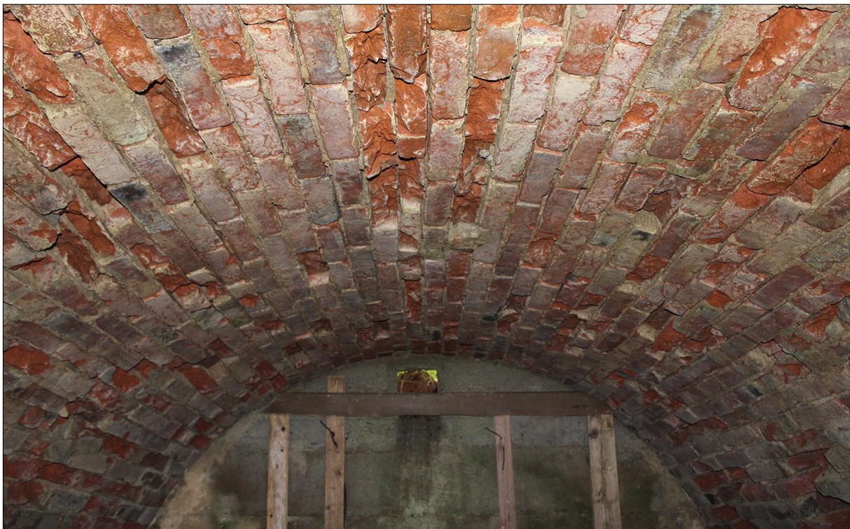
Figur 23. Tunnvalv av återanvänt storstenstegel i jordkällaren (124). Foto från öster.
