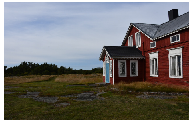
Byggnadsminnet Södergården på Finbo.
