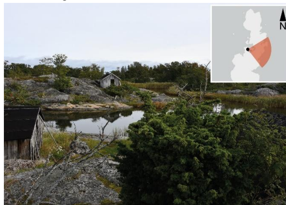
Figur 8.49. Fiskeläget på Lanto grunden är ett exempel på en kulturmiljö där måttlig effekt bedöms uppstå.
