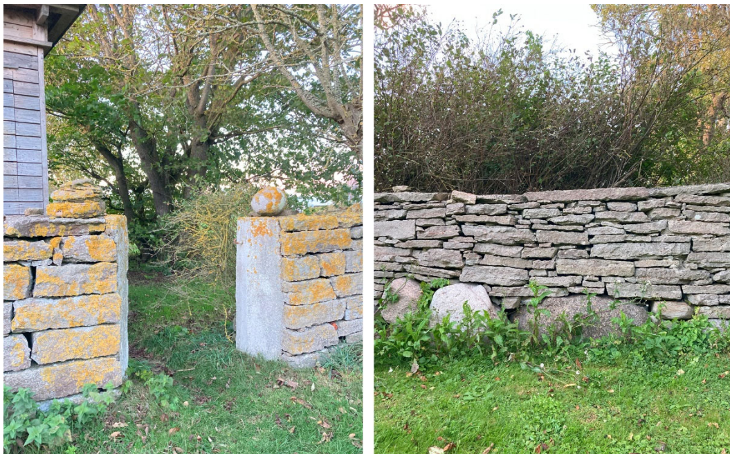
Bilden till vänster. Öppning i muren som av avgränsar trädgården mot norr, FyrmästARBostaden. Bilden till höger. Äldre mur nordväst om Fyrvaktarbostad (1844).
