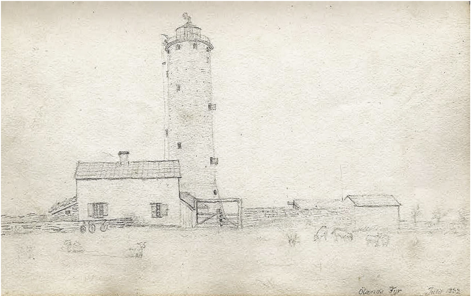
Ölands södra fyr, blyertsteckning Fredrik Arosenius juli 1832. I förgrunden det första fyrvaktarbostället ("skolhuset"). Vid fyrens sockel ses taket från tillbyggnaden som innehöll magasin, vedförråd, kostall mm. Krigsarkivet.
