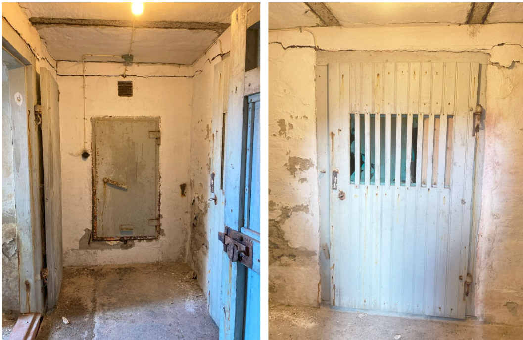
Bilden till vänster. Den norra matkällaren är ombyggd till skyddsrum, troligen under beredskapsåren (1939–45). Bilden till höger. Dörrsnickerier mellersta matkällaren. Ventilerad dörr. I taket syns de ingjutna I-balkarna.
