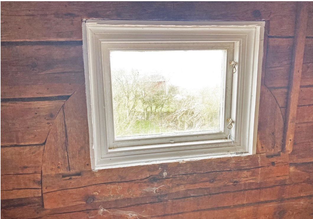
Lagning (1872) av timmerstomme efter ursprungligt lunettfönster (1844).
