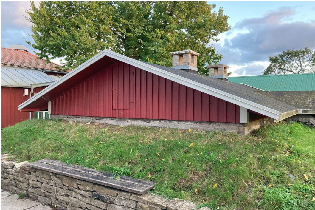
Det tillbyggsda sadeltaket tillkom 1920, tidigare var hela källaren täckt med jord.
