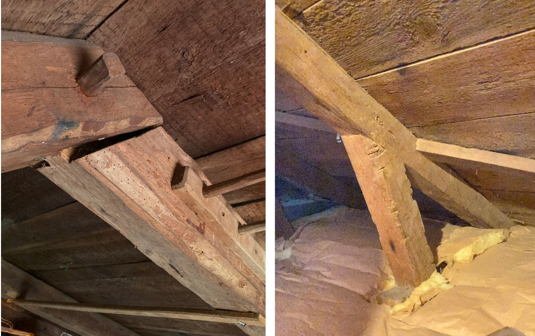
Detaljer på sammanfogningar av takstolar med tappar och dymling. Foto 2024.
