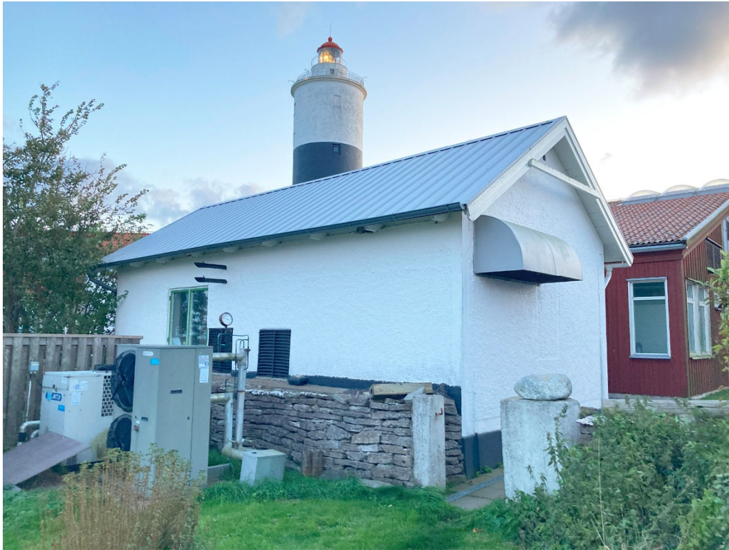
Maskinhuset sett från nordost. I fasadens övre del syns höjningen med två murskift från ombyggnaden 1949.
