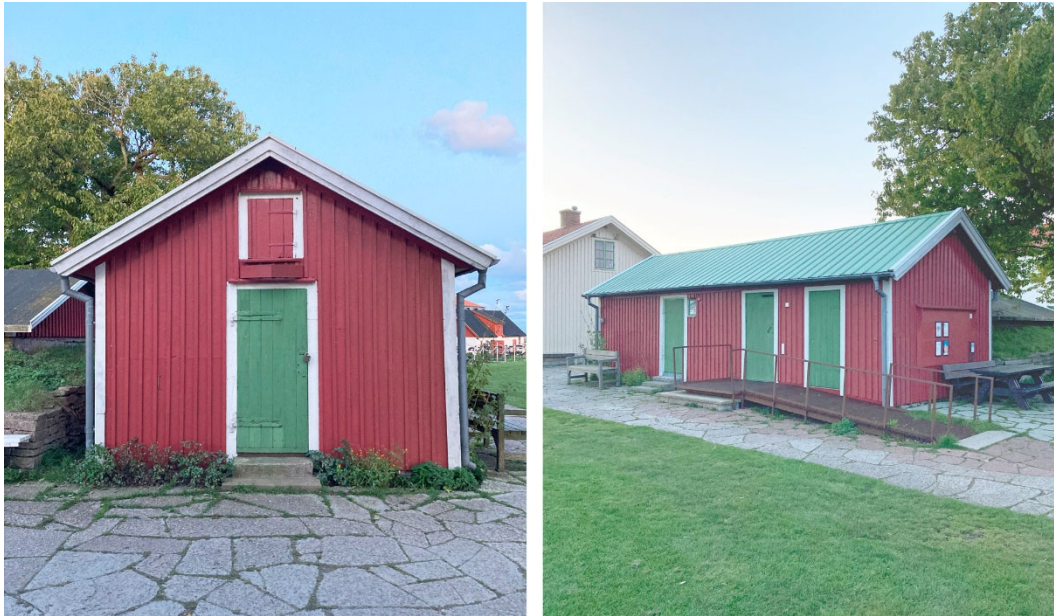
Bilden till vänster. Gavel mot öster (mot fyren) tidigare fanns här en ramp i stället för trappa för att rulla fotogenfaten på en kärre. Bilden till höger. Fasad mot söder med tillgänglighetsanpassad ingång till "kaffestugan"
