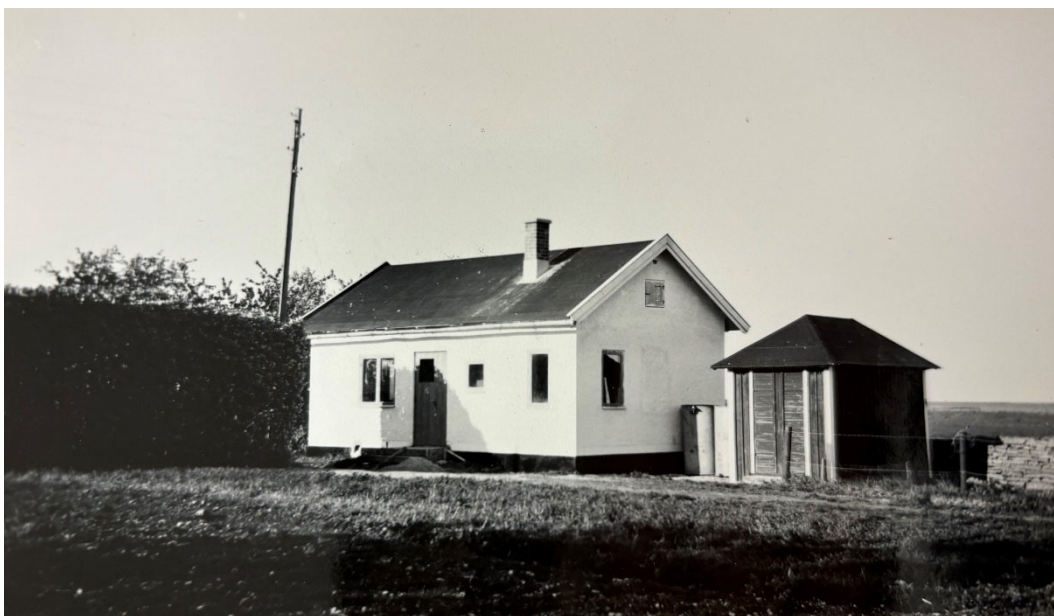
Byggnaden ändrad till Maskinhus för reservkraft till fyrplatsen i händelse av strömavbrott. Till höger det gamla krutförrådet som tidigare stått ute på udden vid mistkanonerna.
