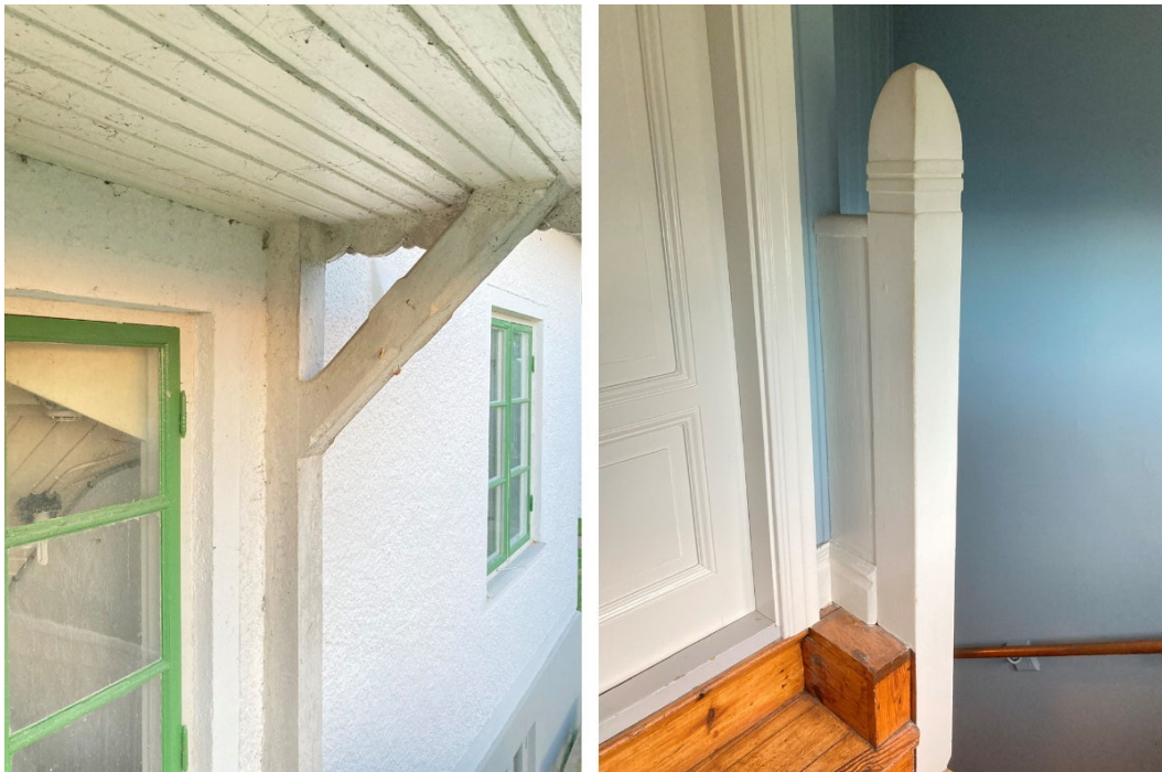
Bilden till vänster. Detalj vid entré, konsol till skärmtak. Bilden till höger, detalj av trappräcke övervåningen. Detaljerna är typiska för den 1920-tals klassicism som i Norden gick under namnet "Swedish grace".
