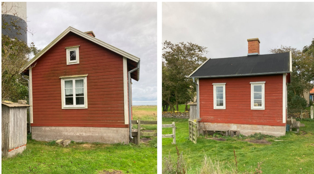
Bilden till vänster. Tvätt- & bagarstugan mot norr, den enda fasaden som hade fönster ursprungligen. Bilden till höger. Fasad mot väster med nya fönster.
