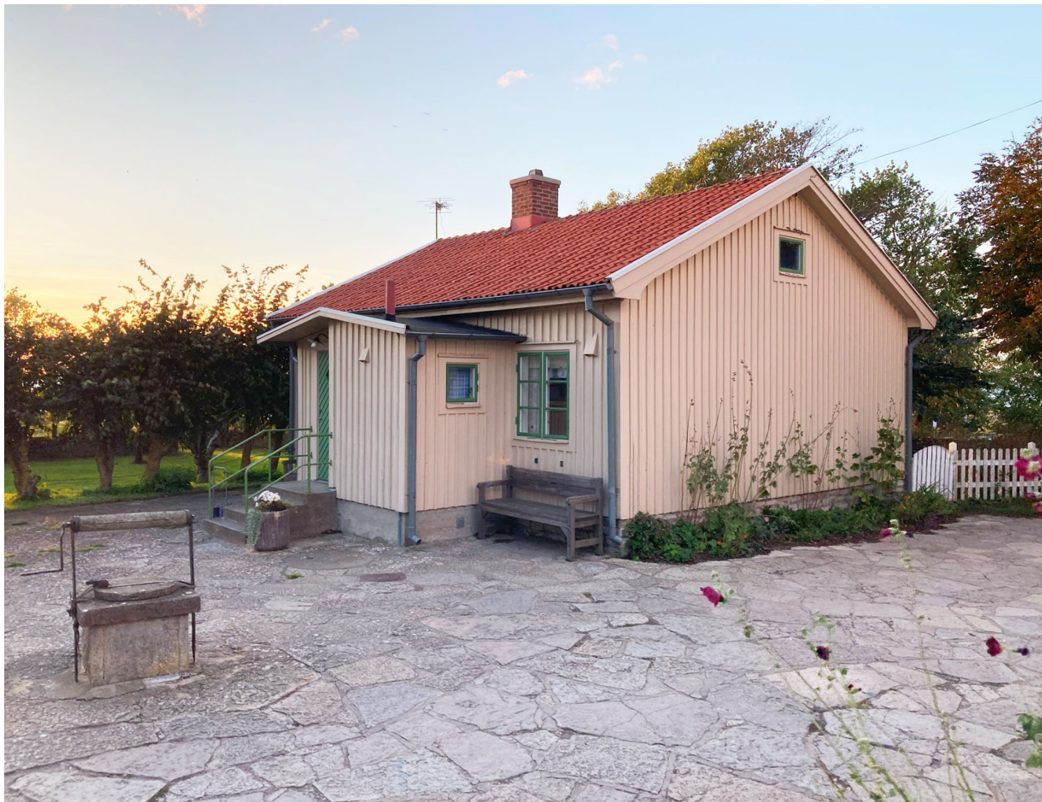
Fyrvaktarbostaden 2024. Byggnaden har förändrats kraftigt under åren genom ett stort antal moderniseringar i takt med höjd boendestandard. Foto 2024.
