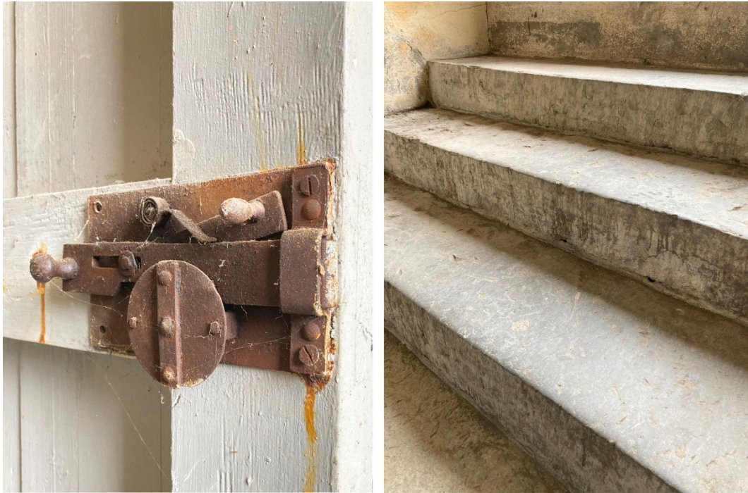
Bilden till vänster. Låskista till matkällarens ursprungliga entrédörr (1898). Bilden till höger. Källarens stentrappa av huggen kalksten (1898), idag delvis överbyggd.
