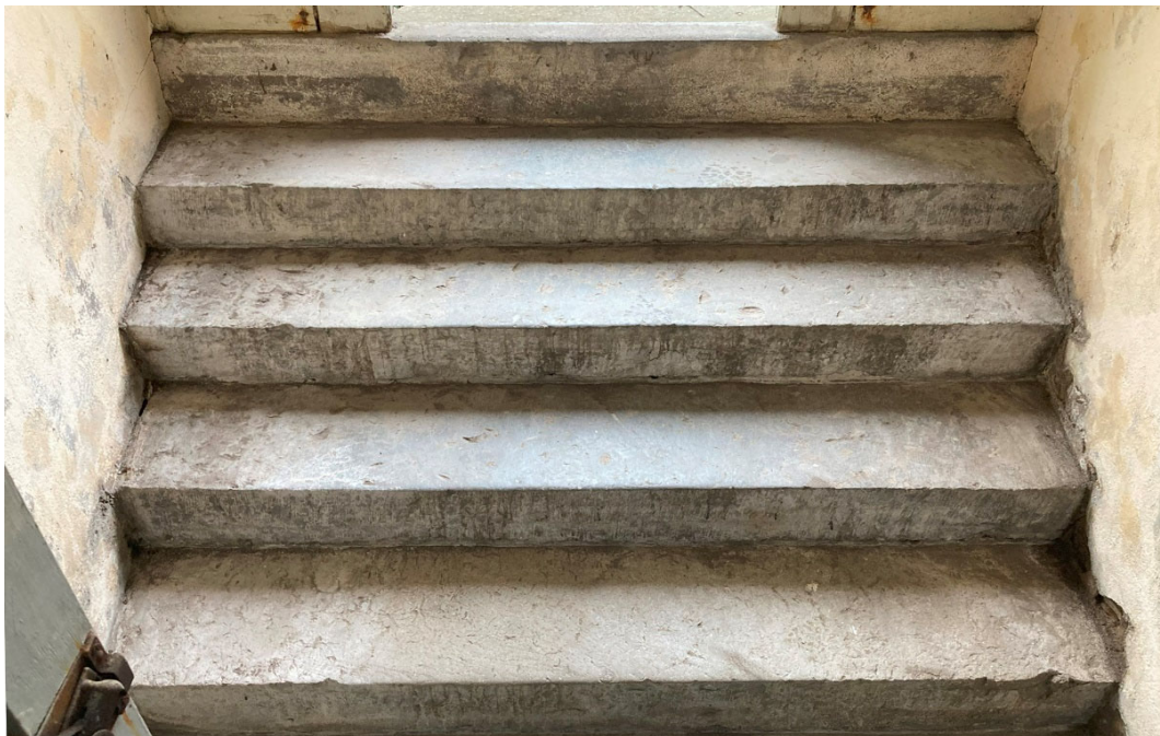
Den vackra stentrappan med massiva trappsteg av kalksten.
