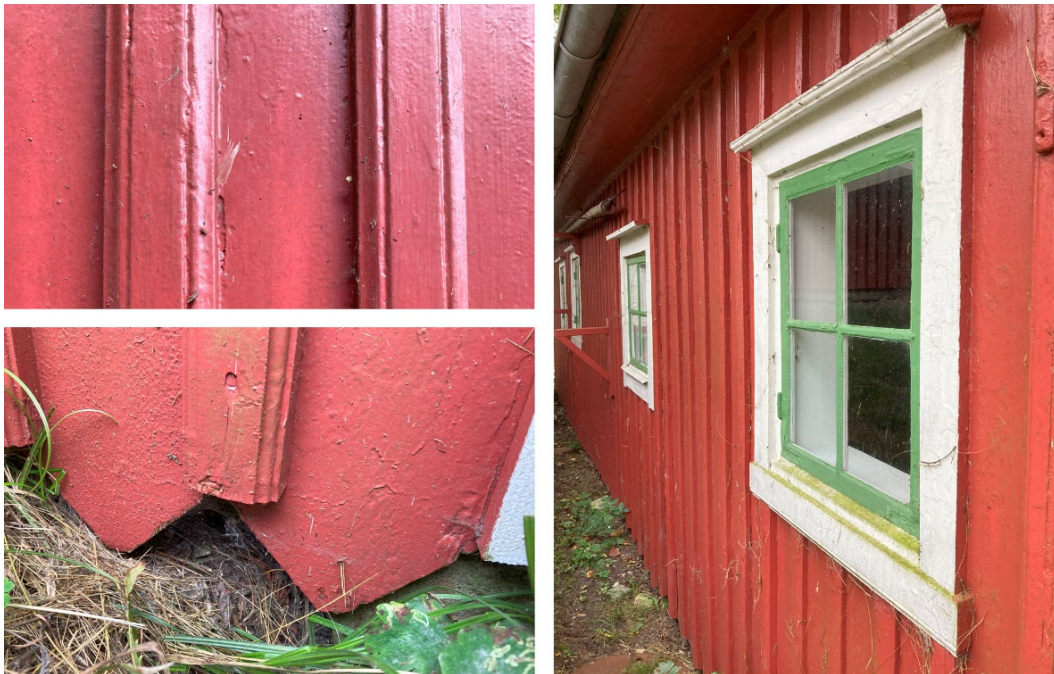
Bilden uppe till vänster. Original profilerade lockläkt, Bark & Warburg AB. Bilden nere till vänster. Sågtandad panel avslut nertill. (panel delvis original). Bilden till höger. Original fönsterfoder och övre vattbräda, Bark & Warburg AB.
