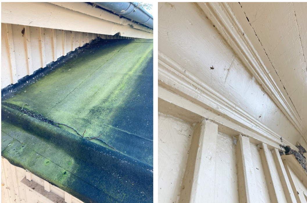
Bilden till vänster. Farstukvist mot norr med helsvetsat papptak. Ett urtag för den ursprungliga, på södra fasaden centrerade nocken, syns ännu i takfoten. Bilden till höger. Utvändigt kraftig taklist av gesimstyp, Bark & Warburg AB.
