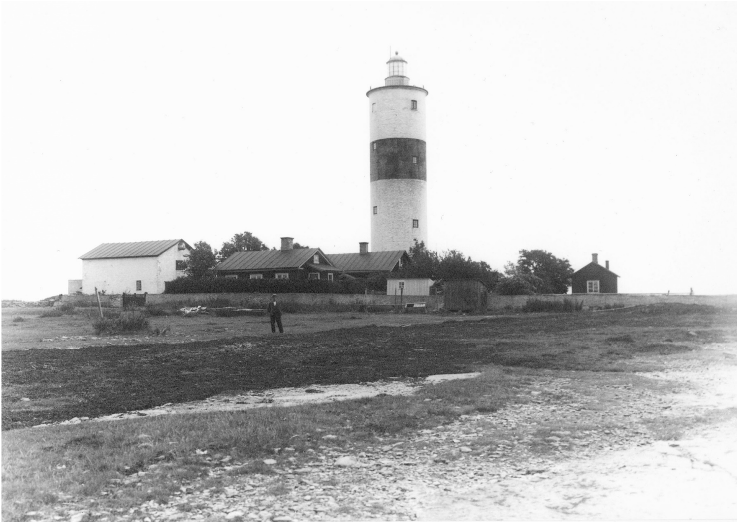
Ölands södra uddes fyrplats 1910. Det högre stenhuset till vänster uppfördes som första fyrvaktarboställe, samtida med fyrtornets färdigställande 1785. Övriga byggnader på bilden tillkom från mitten av 1800-talet. Foto: Kalmar läns museum.
