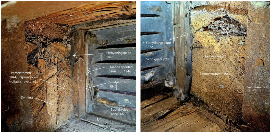
Ett tvärsnitt av byggnadens ytterväggar kan ses i en håltagning för friskluft.
