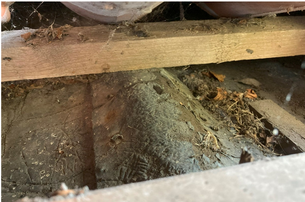
Ursprungligt papptak lagt med s.k. listtäckning. Tjärpapp struken med stenkoltjärna. Norra takfallet, det sista kvarvarande papptaket med listtäckning på ÖSU. Foto 2024.
