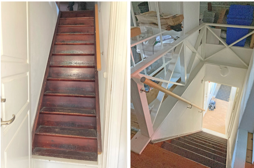
Bilden till vänster. Vindstrappa från 1872 men flyttad till detta läge 1920. Bilden till höger. Trapphållsräcke 1872, men flyttat till nuvarande läge vid ombyggnad 1920. (Handledare 1990-tal)
