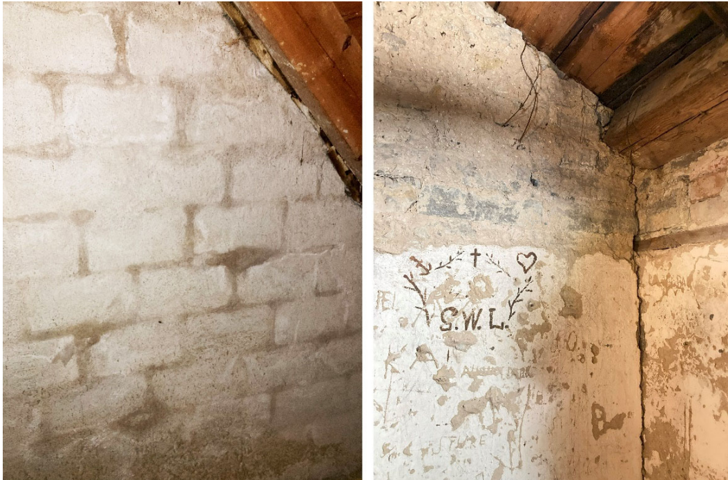
Murverk från olika sekel. Bild till vänster. Fyrmästerbostaden uppförd 1920 är murad av s.k. Lean-tegel. Bild till höger. "Skolhuset" med murverk av kalksten sent 1700-tal.
