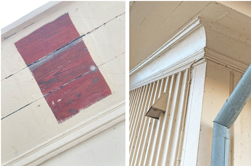
Bilden till vänster. En sparad ruta av den ursprungliga rödfärgen, taksprång mot öster. Bilden till höger. Den ursprungliga gesimslisten av trä mellan panel och taksprång.
