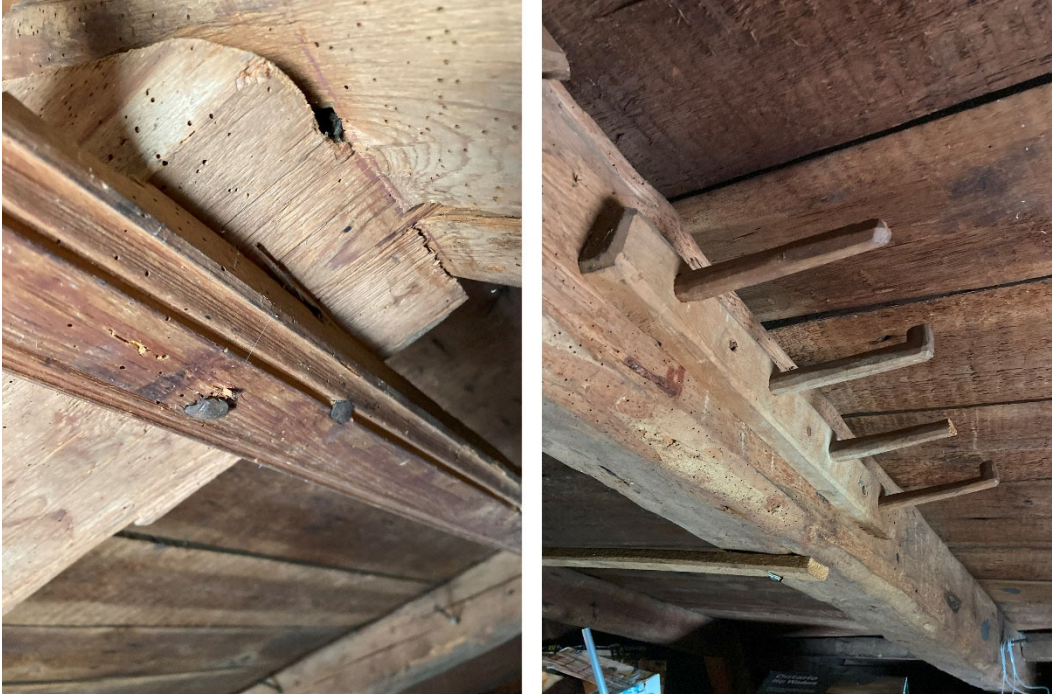
Bilden till vänster. En profilerad locklist (Bark & Warburg AB) är återbrukat till torkställning eller liknande. Bilden till höger. Egenhändigt snidade krokar infästa i takstol.
