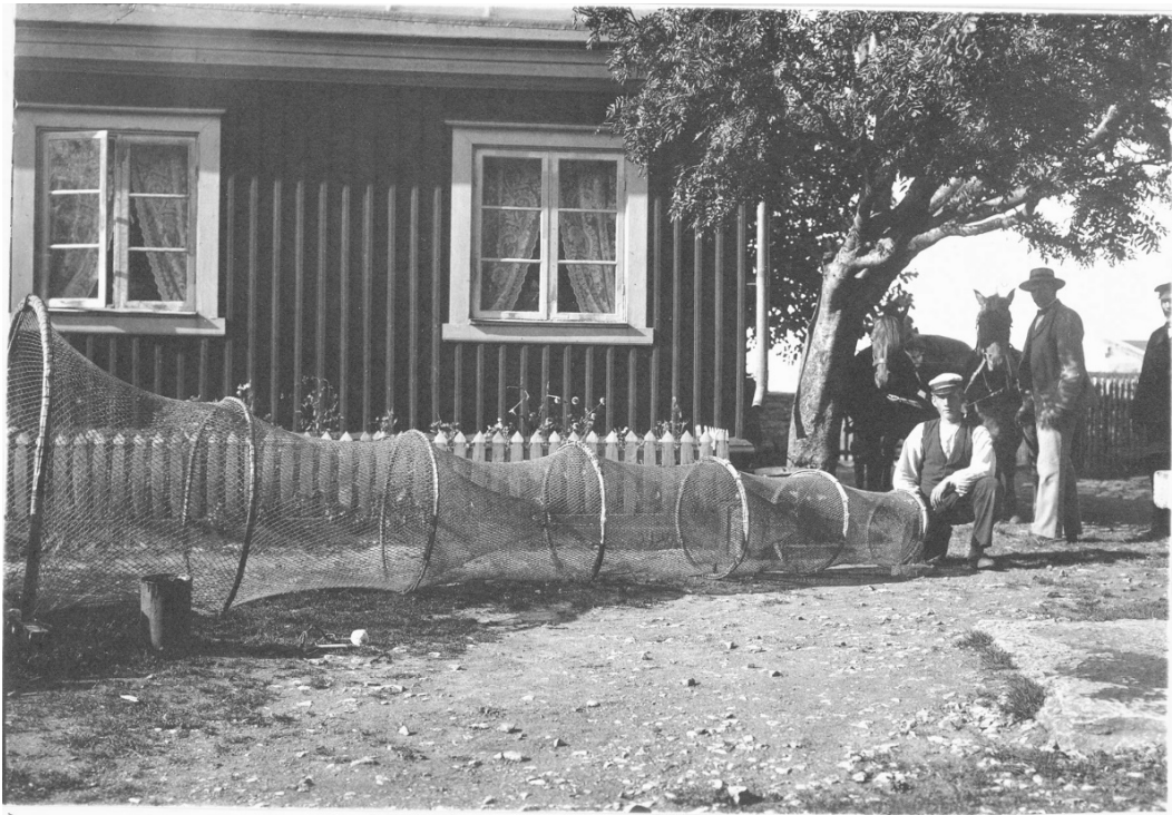
Fyrvaktarbostaden klädd i rödfärgad sponthyvlad panel med profilerade locklister. Panelen avslutas mot en sluttande kraftig vattbräda. Foto: Johan Emanuel Thorin, 1906, Kalmar Museum.
