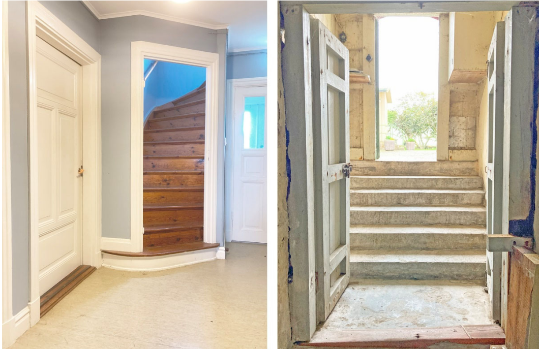
Bilden till vänster. Fyrvaktarbostadens trapphall med bevarade spegeldörrar, listverk & trappa (1920). Bilden till höger. Källarbyggnadens ursprungliga entrédörr och stentrappa (1898).
