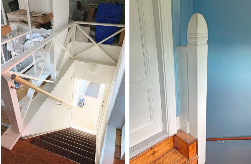
Bilden till vänster. Trapphålsräcke vind Fyrvaktarbostad uppförd 1872. Bilden till höger. Fyrmästarebostadens trappräcke/stolpe på övervåningen. Det mesta utgörs av originalsnickrier från 1920.
