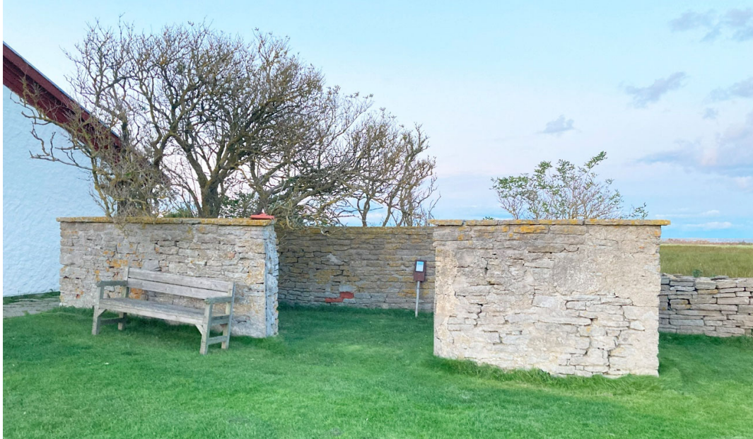
Bilden till vänster. Det öppna rummet mot söder. Bilden till höger. Rummet mot norr.
