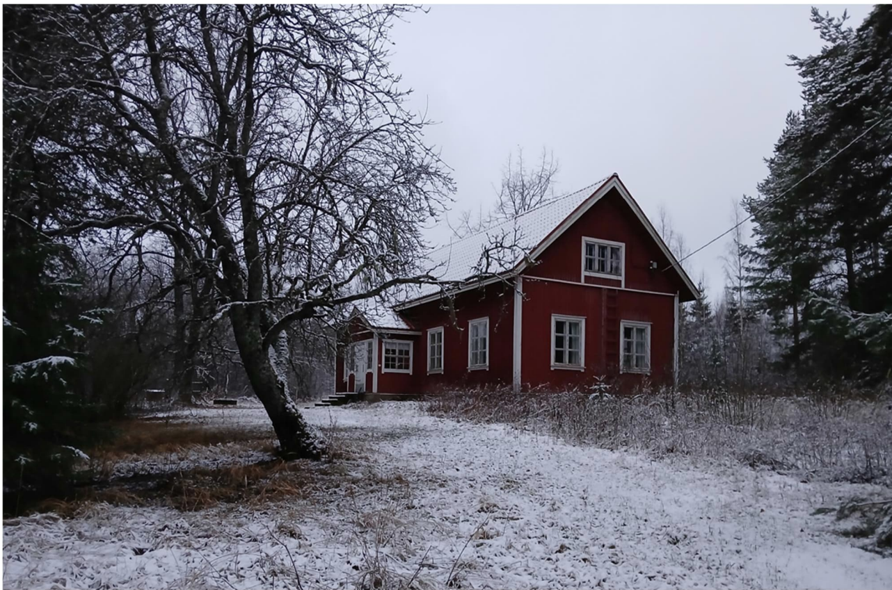
Bild 11. Huvudbyggnaden på Liukko gård i november 2025. Foto: Erja Soranta.
