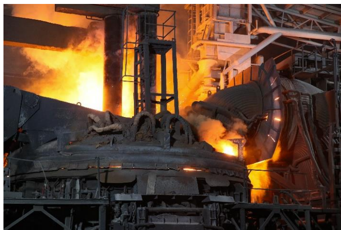
Bild 4: Ljusbågsugn (AC-variant), elektrodena syns centralt i övre delen, utsug till höger i bilden.
