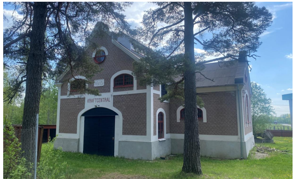
Kraftcentral vid Mimerlaven, Norberg
