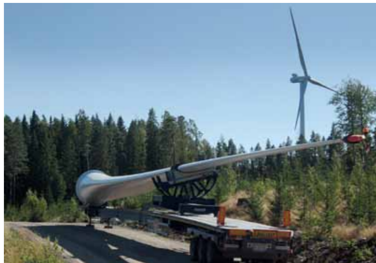
➤ Maskiner och fordon höjer aktivitetsnivån i landskapet. Många vilda djur lämnar därför området under tiden när vindkraftverk byggs.
